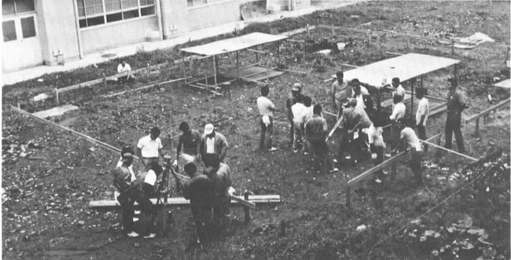
(鉄筋コンクリート造実習)
