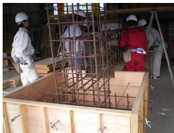
配筋・型枠実習
