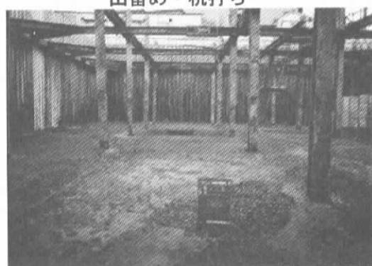
山留め支保工
