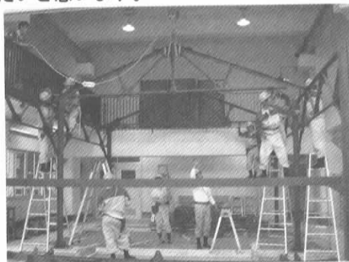
鉄骨組立て実習
