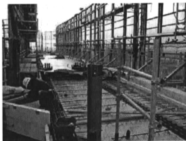
住宅棟の屋上
