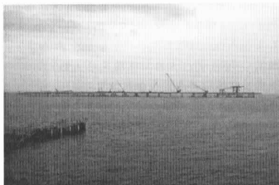
海上からのD滑走路工事現場 →
