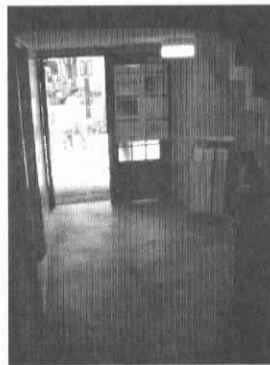
「同潤館」入口内部
