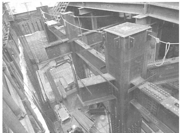
浅草文化観光センター改築工事 現場
