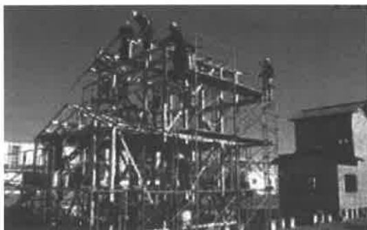
授業で戸建住宅を建設
