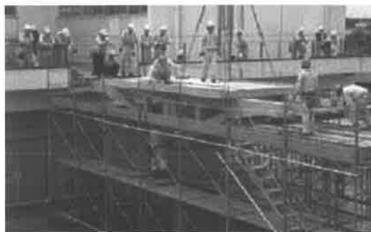
授業で本物の連絡橋を建設
