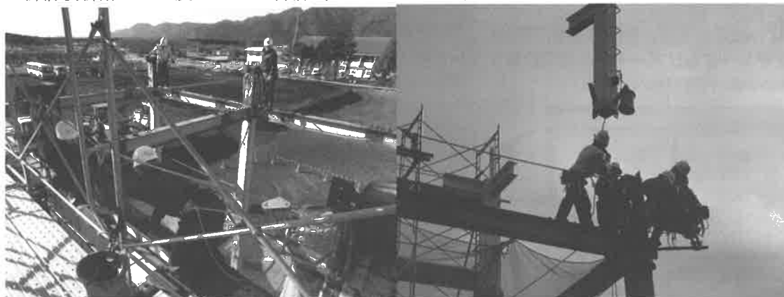
富士教育訓練センターでの鉄骨建方実習
