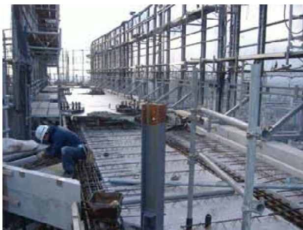
住宅棟の屋上
