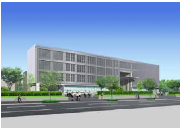
現在工事中の新校舎
