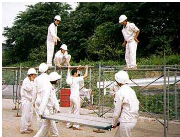
足場組立実習
