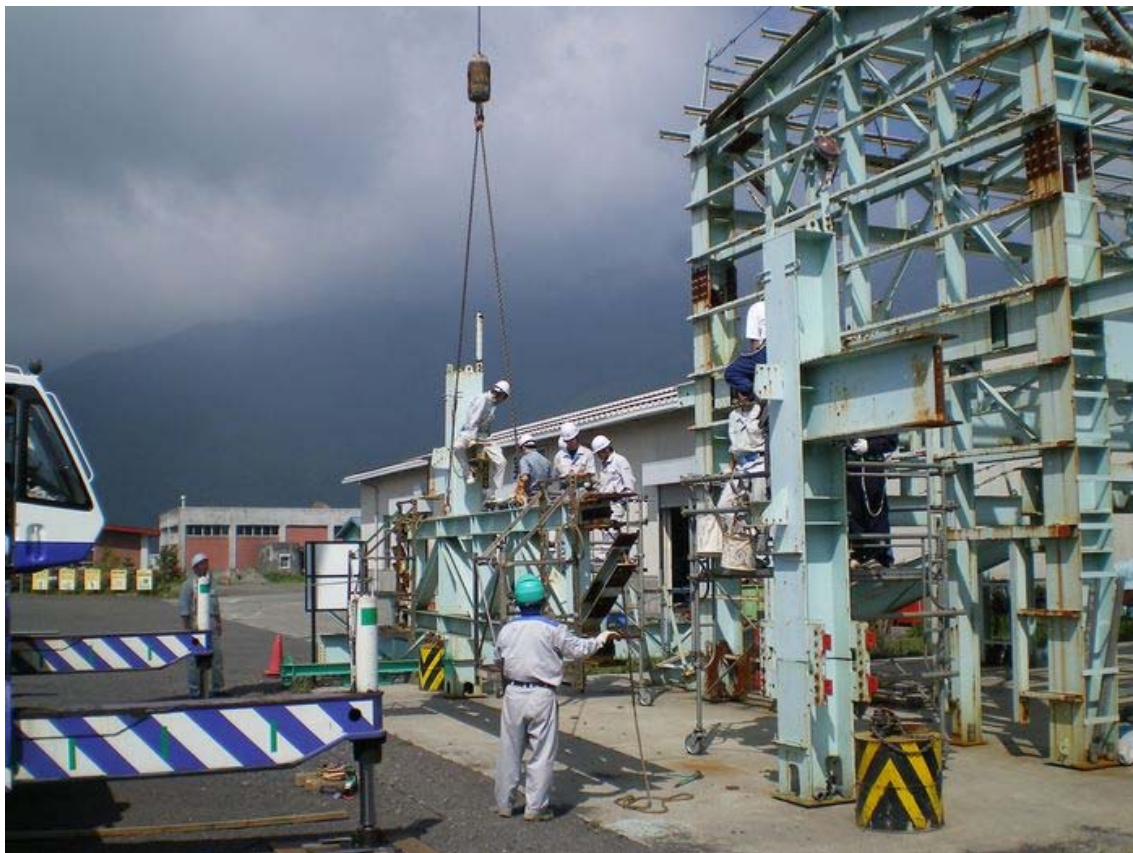
鉄骨組立実習
