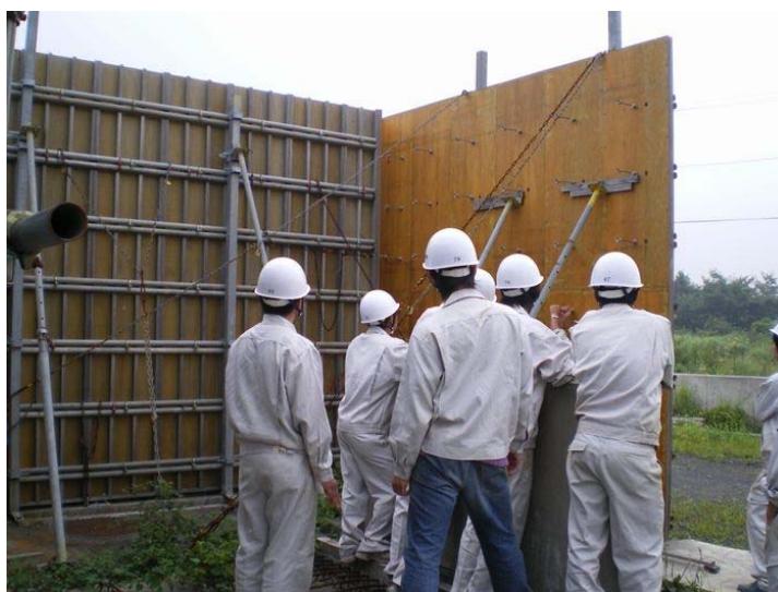
型枠組立実習
