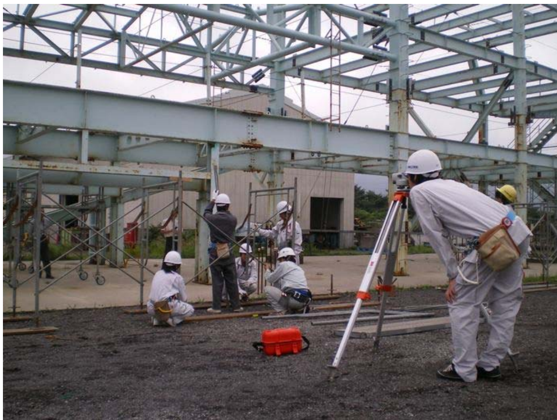
足場組立に伴う測量実習
