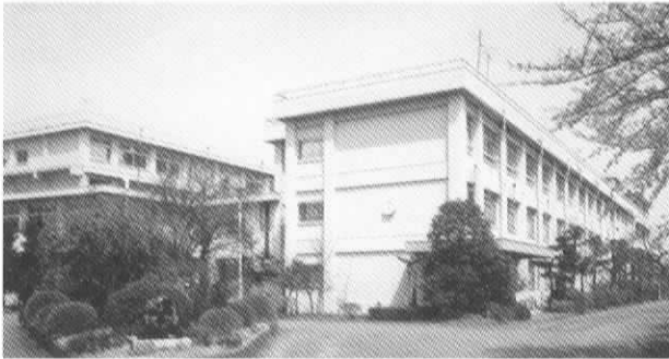
県立向の岡工業高等学校（全） 川崎市多摩区堰 1-28-1
