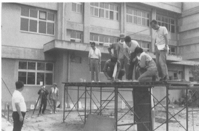
昭和47年第1回施工実習研究協議会 RC造 墨出し実習 (於 横須賀工高)
