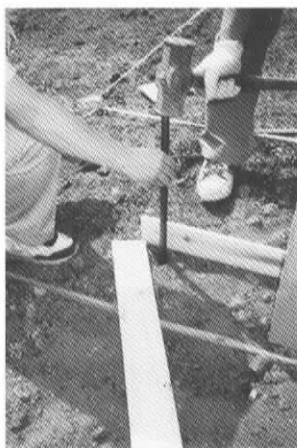
平成4年施工実習研究協議会 水盛りのやり方(水ぐいの穴あけ)
