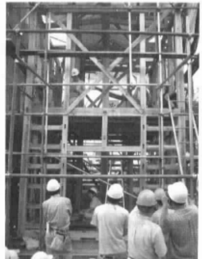
東京建築カレッジ 練馬実習場 貫構法の実験
