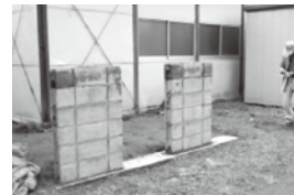
写真5・6 竹筋コンクリート基礎製作③
