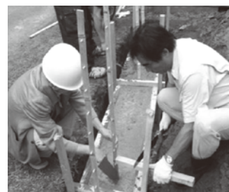
写真5・6 竹筋コンクリート基礎製作③
