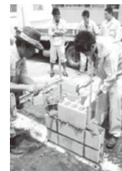
写真5・6 竹筋コンクリート基礎製作③
