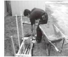
写真3・4 竹筋コンクリート基礎製作①②
