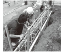
写真3・4 竹筋コンクリート基礎製作①②
