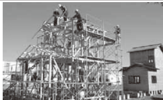
授業で戸建住宅を建設
