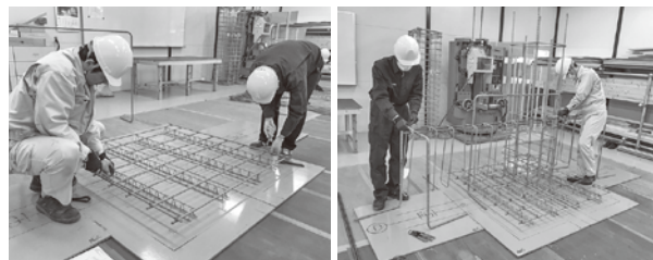
図1 鉄筋組立て実習
