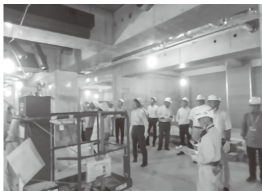
建設現場見学(清水建設)
