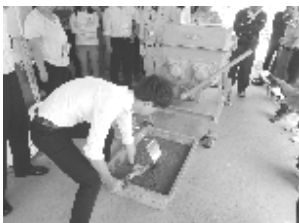
練り混ぜ状況
