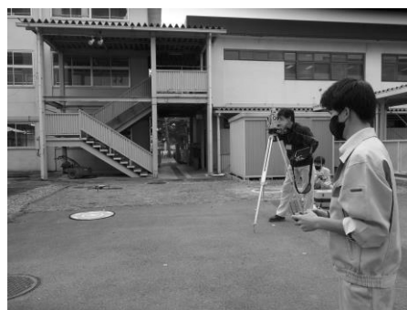
ドローンによる調査の様子
