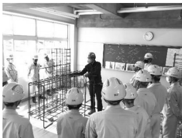
鉄筋施工の様子
