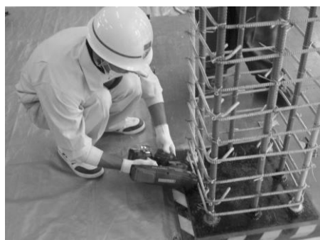
鉄筋組立ての様子
