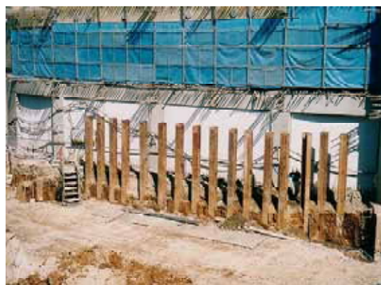
山留め・杭打ち
