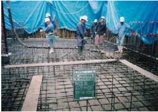
コンクリート打ち
